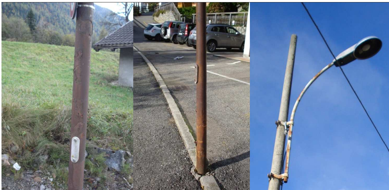
Fig. 3.9 – Esempi di sostegni con segni di corrosione
